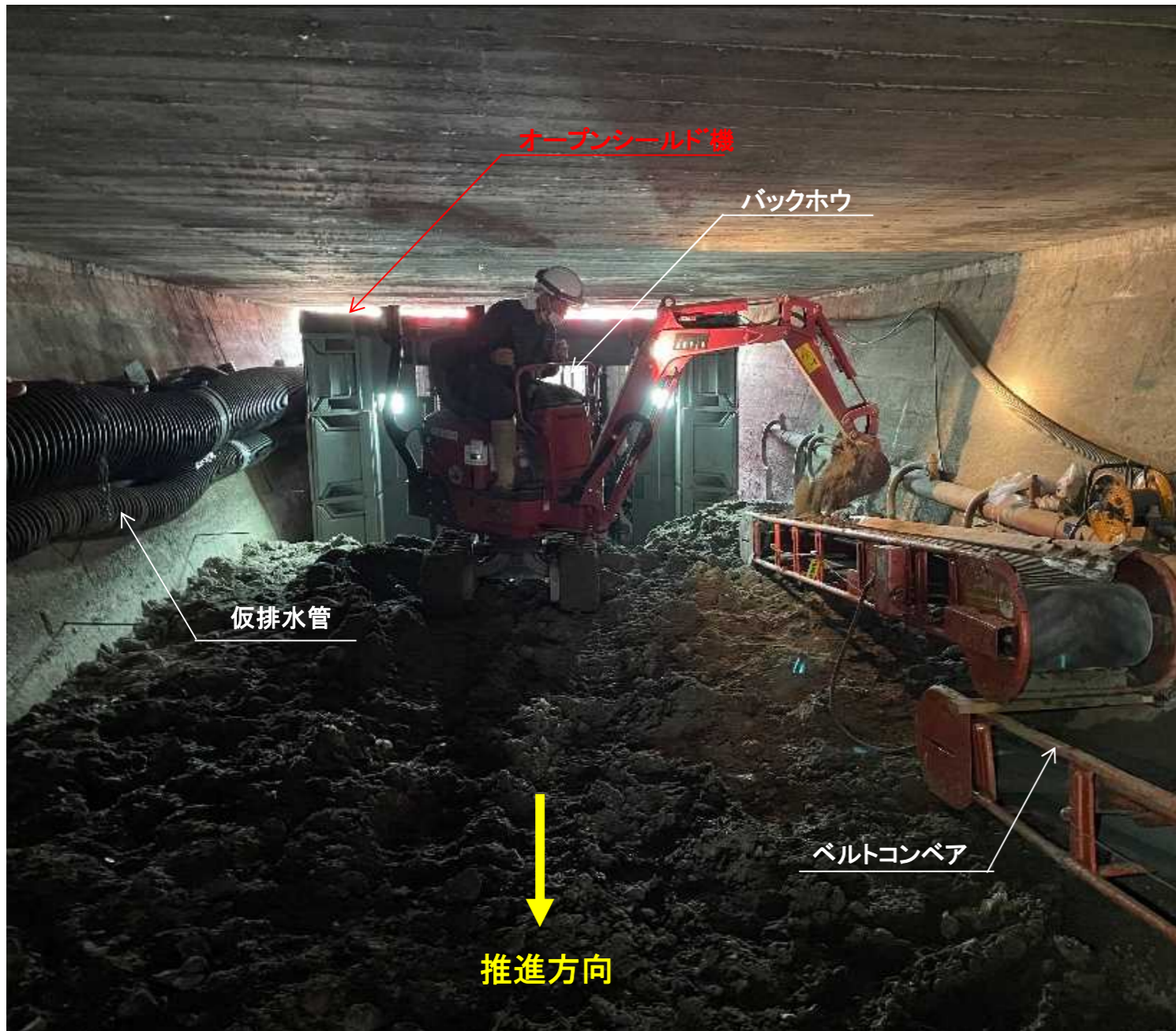
施工状況：オープンシールド機掘進状況
