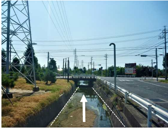
施工前状況：発進側から到達側を見る
