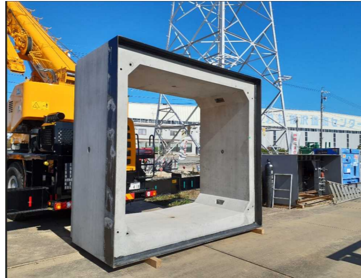
施工状況：オープンシールド工法用函体(NOSⅢ型)
