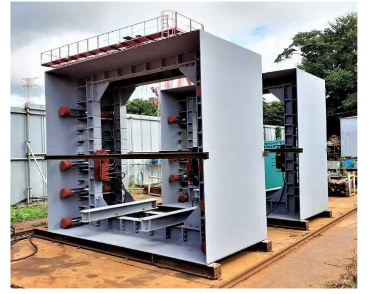
施工状況：中押し設備
