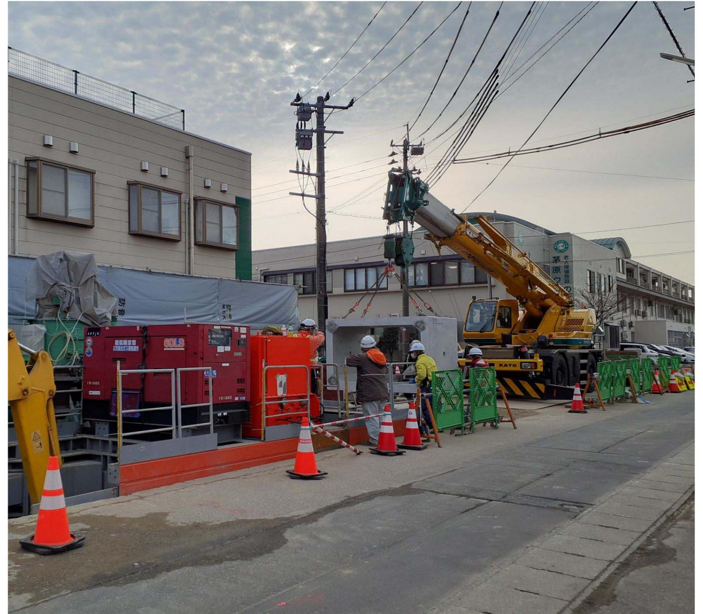
△ 施工状況 : ボックスカルバート吊り下ろし状況
